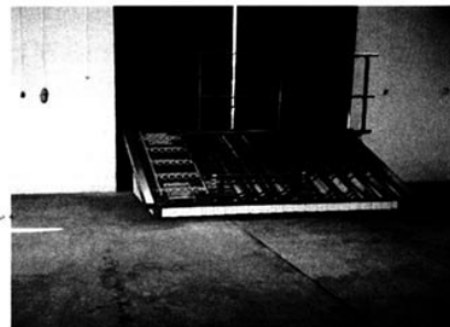
Fragment dachu pokrytego blachą z zamontowanym fragmentem systemu przeciwupadkowego.
