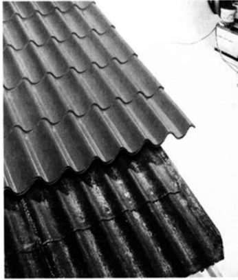
Blacha Handy 107, stosowana jako przykrycie płyt azbestowo-cementowych
