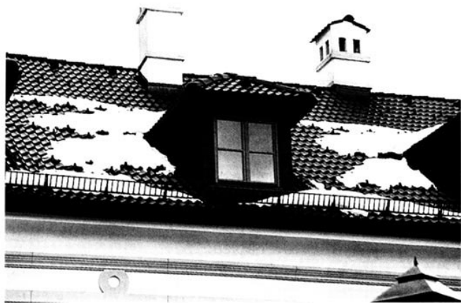
Dach w Niemczech. Widoczny płotek przeciwnięgowy i rozpruwacz śniegu. Lukarna obrobiona łupkiem
