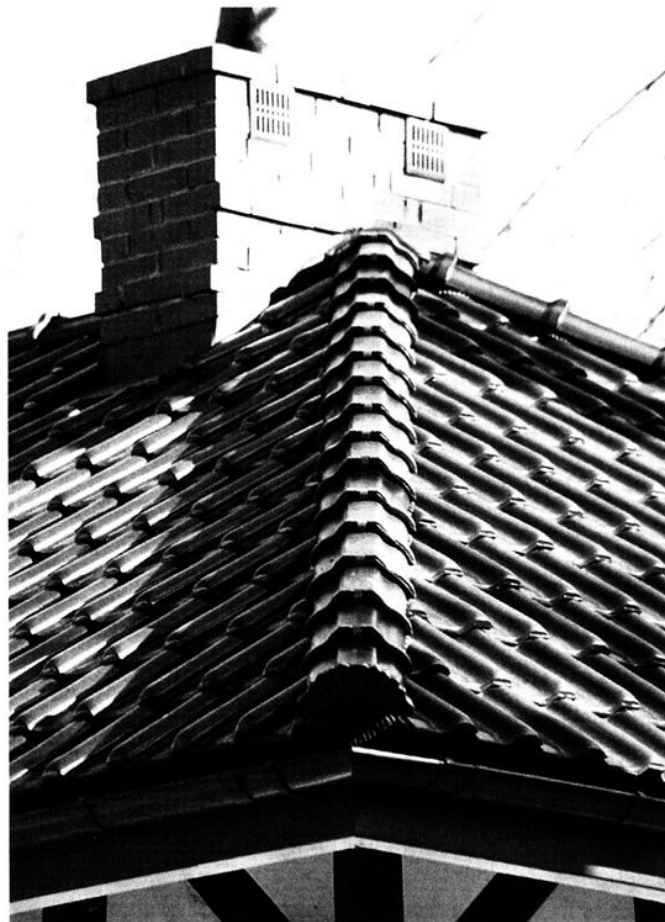
Typowe polskie rozwiązanie. Deska czołowa obrobiona blachą płaską, rynna zamontowana do deski czołowej, widoczna taśma pod gąsiorem i kłamra do gąsiora
